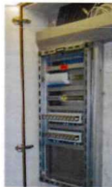
1 Asbesthaltige Leichtbauplatten, z. B. als Brandschutzverkleidungen im Inneren von Elektrochränken, hier Türverkleidung
