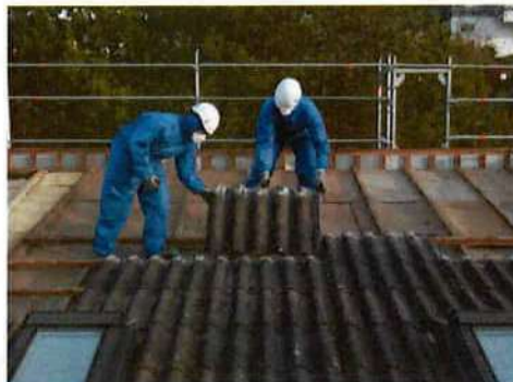
3 Um Gesundheitsgefährdungen zu vermeiden, ist die Demontage zerstörungsfrei und mit der richtigen Schutzausrüstung auszuführen.
