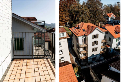
AUSFÜHRUNGSBEISPIEL BALKONVORBAUTEN UMBAU POSTSTRASSE 29 STAHLKONSTRUKTION DUPLEXIERT, GELÄNDER FLACHSTAHL, FLÜGELN KUNSTSTOFF
