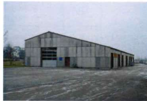
1 Mit Wellplatten aus Faserzement verkleidete Industriehalle
