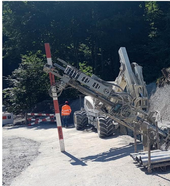
Erstellung Bodennägel und Mikropfähle
