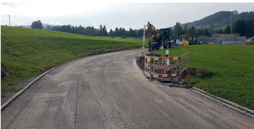
örtlicher Ersatz Strassenabschlüsse, best. Deckschicht gefräst
